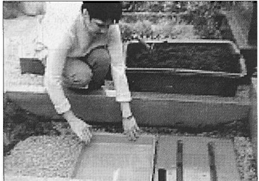
Einbau leicht gemacht: Hier werden die Wannen eingelegt!
