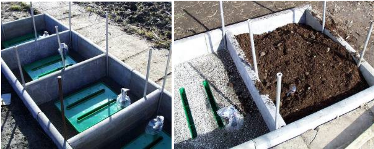
Abb. 1: Einbau der Wasserspeicherkästen auf den Versuchsflächen zur Grabbepflanzung im Frühjahr 2008
